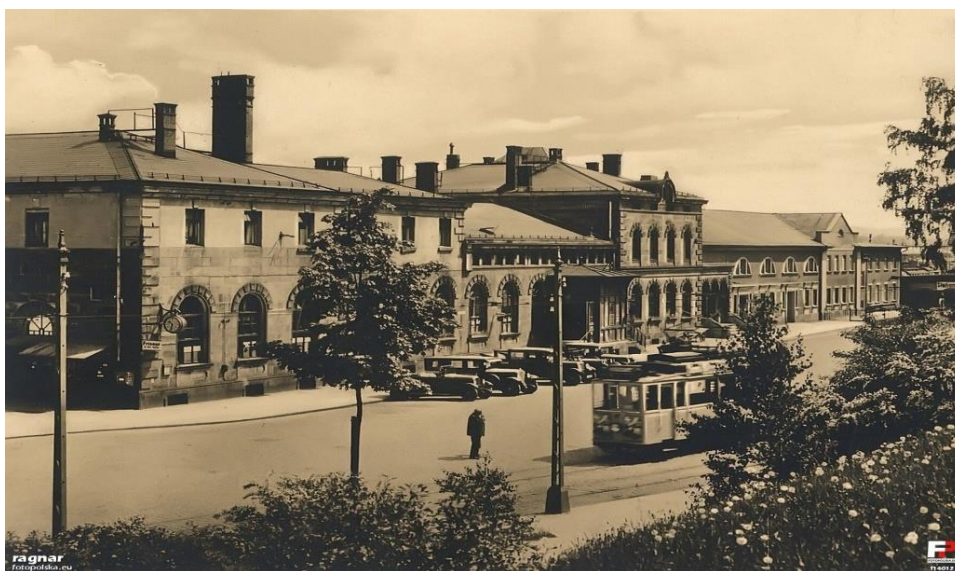
Pętla tramwajowa Dworzec Kolejowy w Jeleniej Górze (fot. Fotopolska.eu)
